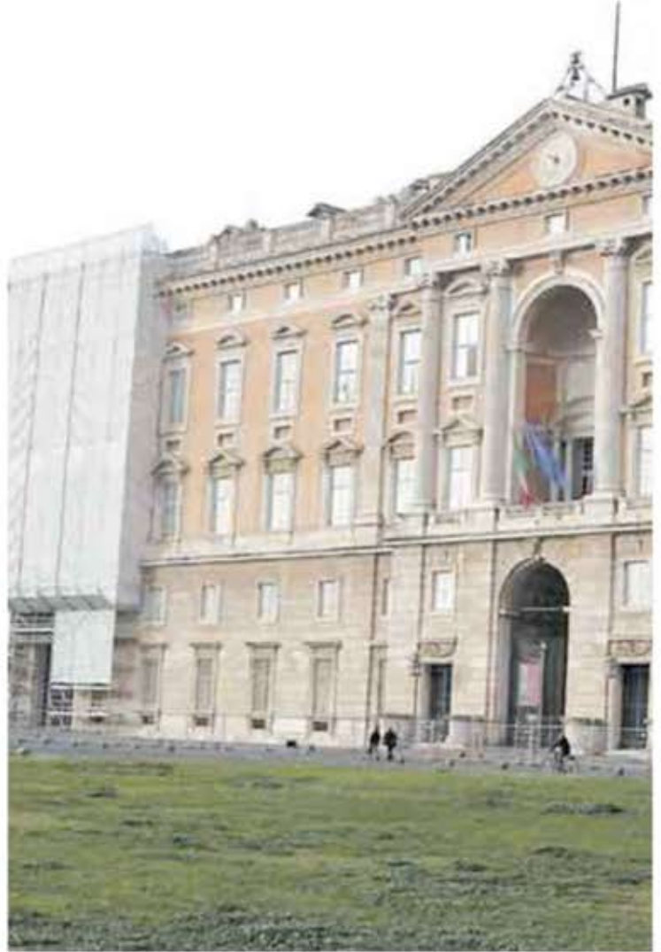
La facciata è stata divisa in terzi, il primo è finito all'80% mentre il secondo al 30%
