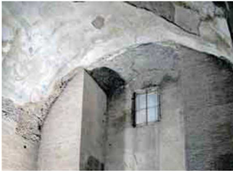
Scorcio della sala delle Civette dopo i lavori di restauro
