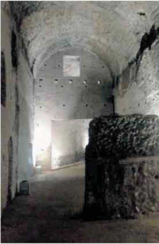
Il percorso d'ingresso della Domus Aurea
